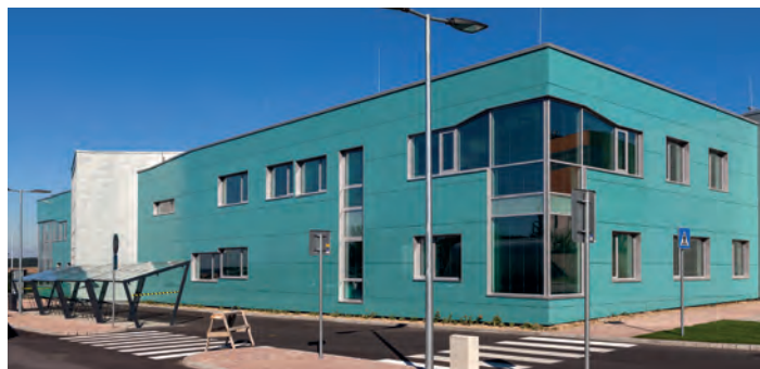
Dokončená budova nového infocentra od areálu elektrárne.
